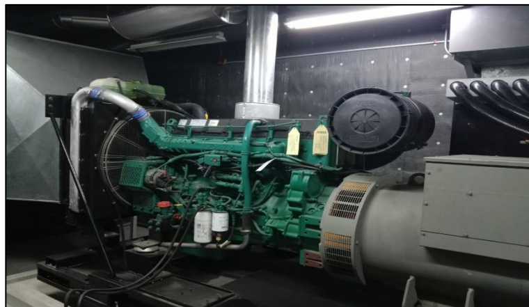
ภาพที่ 2- 24 ระบบไฟฟ้าสำรองฉุกเฉิน
